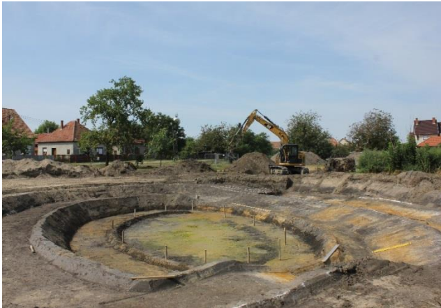
Obr. 33. – Vytvorenie rozmanitej, nerovnomernej geometrie dna v obci Ruzsa. Ploché spády sa striedajú s viacúrovňovými obrubnicami, ich vytvorenie si od zhotoviteľa vyžadovalo viac pozornosti a práce, a v porovnaní s použitím najprudšieho spádu ešte aj znižujú objem nádrže. Ale plochý breh je zároveň bezpečný a poskytuje pestrý biotop pre vznik vodnej flóry a fauny. (Foto: Farkas V. Mátyás, HU)
