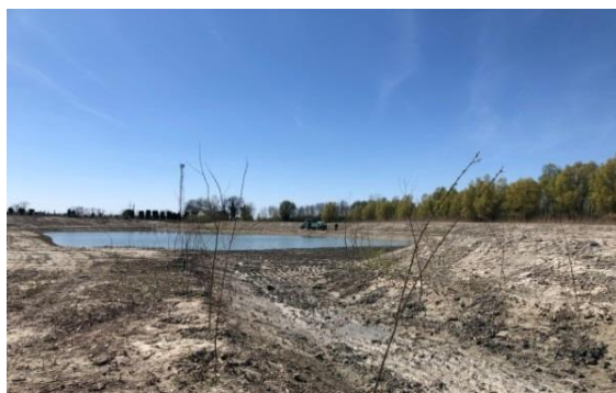
Obr. 19. – Realizačné zemné práce v obci Bátya. (Foto: Szabó Zsófia, Bátya)
