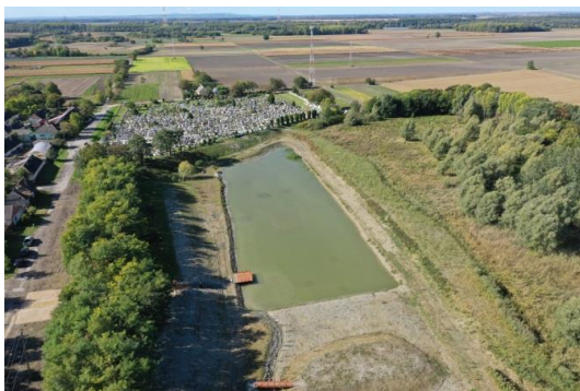
Obr. 22. – Realizovaná investícia: viacnádřové jazero – zrážková nádrž s otvorenou vodnou plochou. (Foto: Filmever Stúdió)
