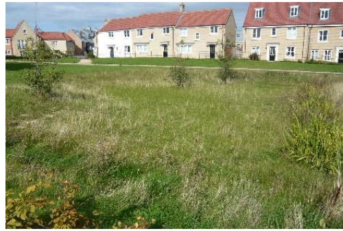
Obr. 10. - Zrážková nádrž vhodná na dočasné zaplavenie, ktoré slúži aj ako zelená plocha. (Zdroj: susdrain.org)
